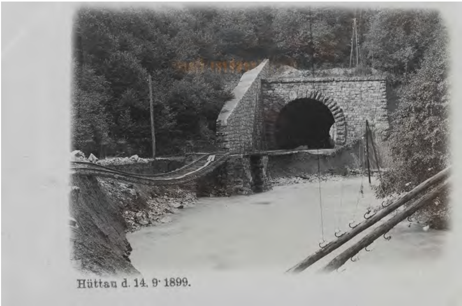
Abb. 4: Die unterspülten Gleise der Ennstalbahn und der hochwasserführende Fritzbach bei Hüttan am 14. 9. 1899.
