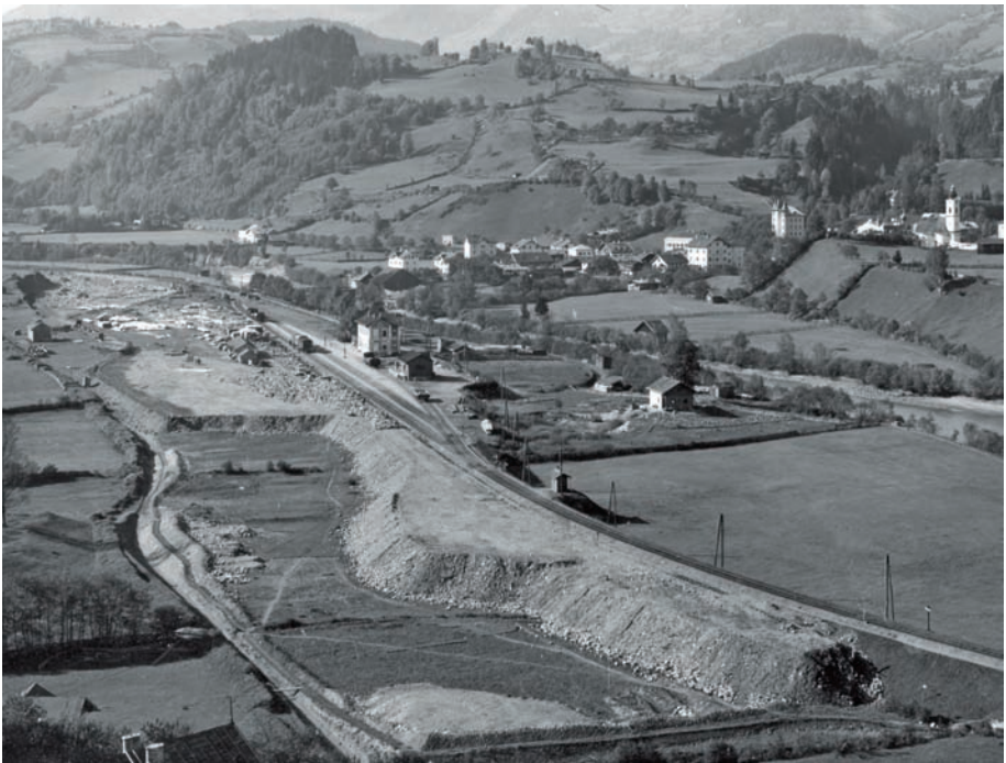
Erdarbeiten am Bahnhof Schwarzach (Fotos Museum Tauernbahn).
